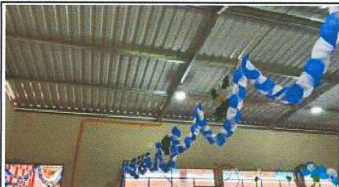
Foto 2: Se observa el Sistema Eléctrico remodelado
