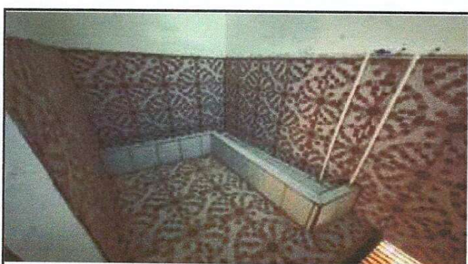
Foto 4: Mantenimiento de Sanitarios y mingitorios con azulejos
