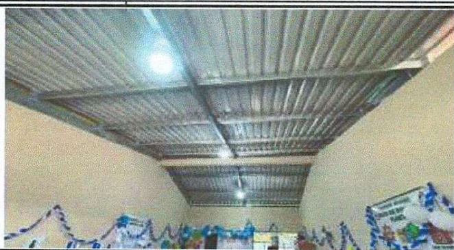
Foto1: Estructura de Techo y cubierta de lámina.
